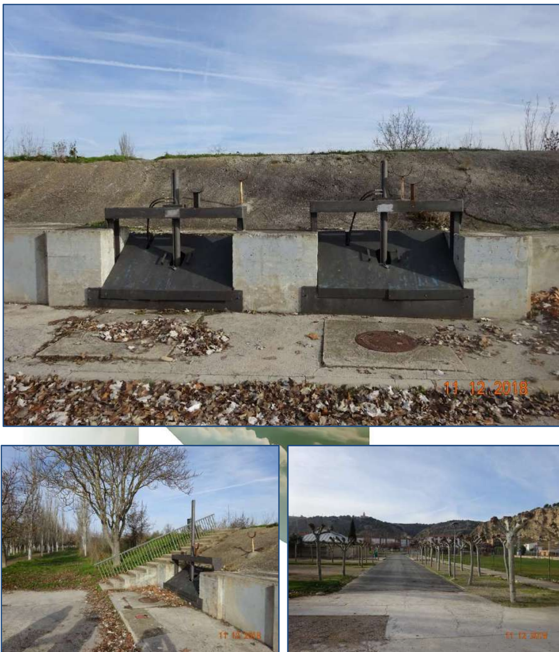
Ilustración 35. Vista de las compuertas (3 compuertas) que regulan la salida del barranco de El Pilón al río Arga, en la zona más baja de la calle San Andrés.
