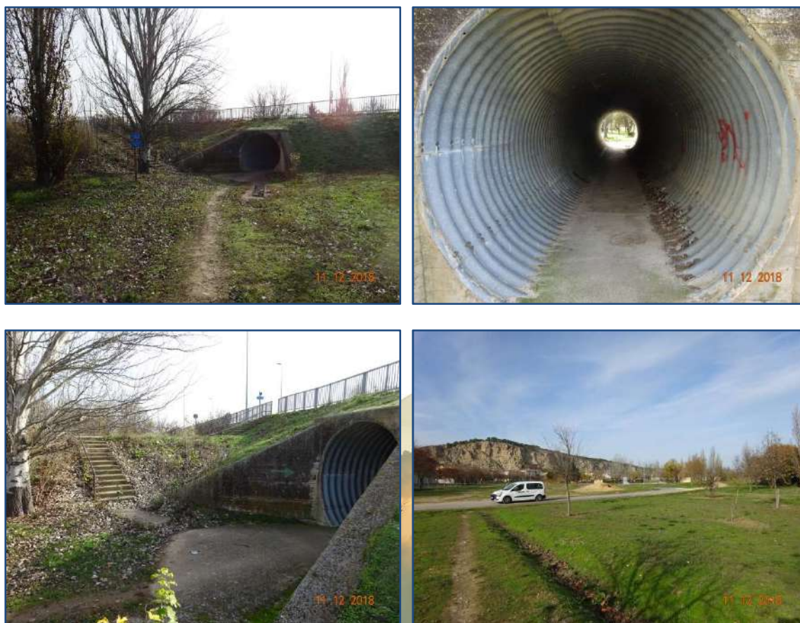
Ilustración 39. Paso inferior bajo la carretera NA-6210 en la margen derecha del río. Esta permeabilización del talud de una infraestructura importante, como es esta carretera, permite evitar embalsamientos importantes en esta zona. En la margen derecha del Arga a la altura del casco urbano es difícil que se produzcan desbordamientos por coronación de la mota por su elevada altura sobre el río, pero sí pueden darse filtraciones que provoquen embalsamientos y encharcamientos en esta margen, por lo que esta canalización, en forma de tubo, de gran diámetro puede dar continuidad a caudales importantes.
